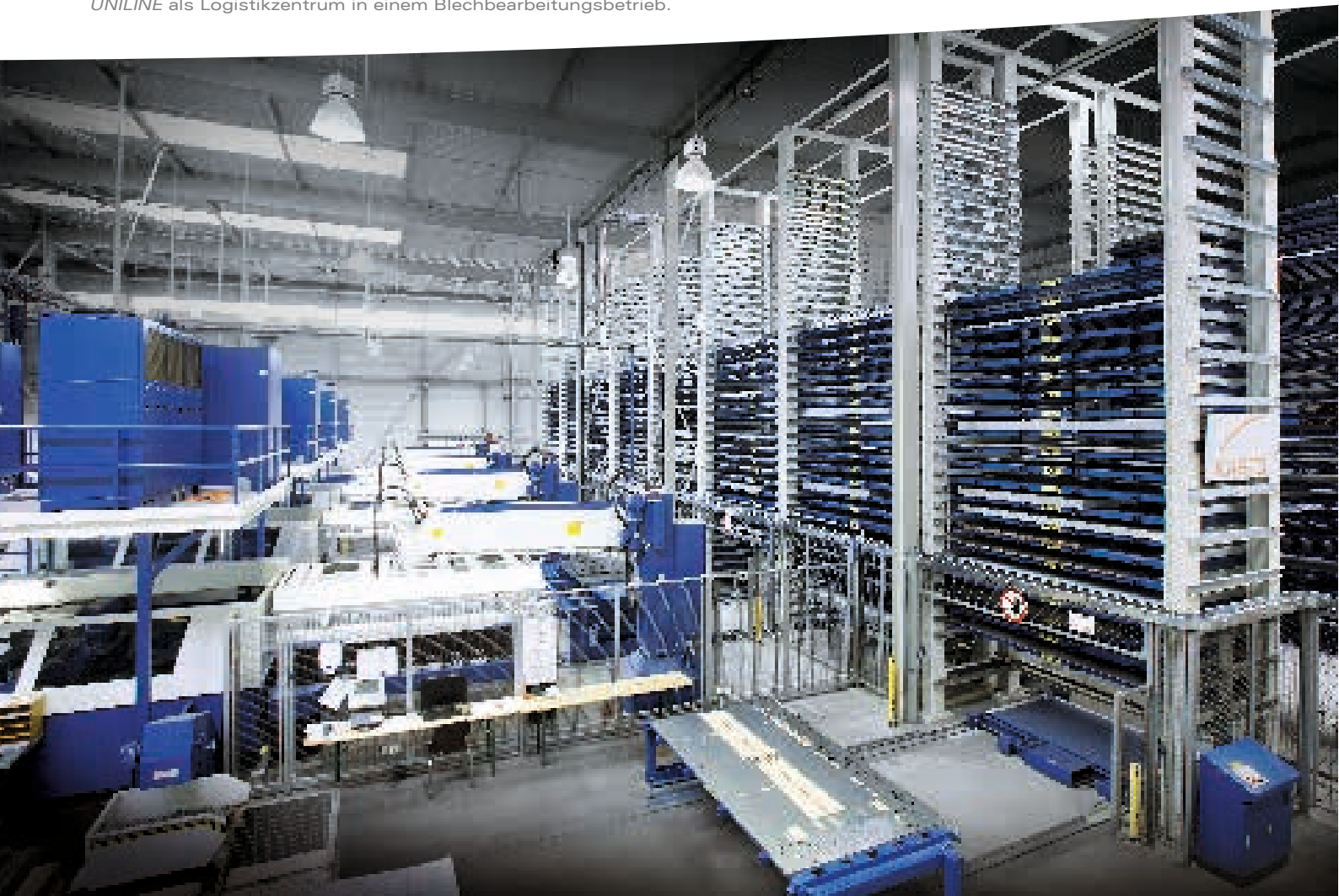
UNILINE als Logistikzentrum in einem Blechbearbeitungsbetrieb.
