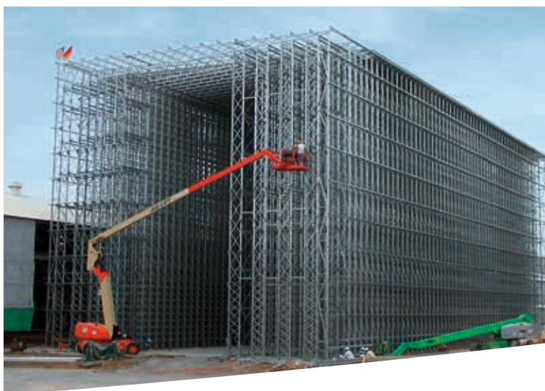
Fertigstellung eines Wabenlagerstahlbaus mit Dach- und Wandanschluss.
